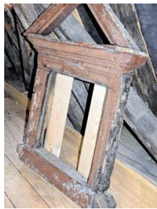
Vor allem der Dachstuhl war völlig marode und wurde erneuert.
