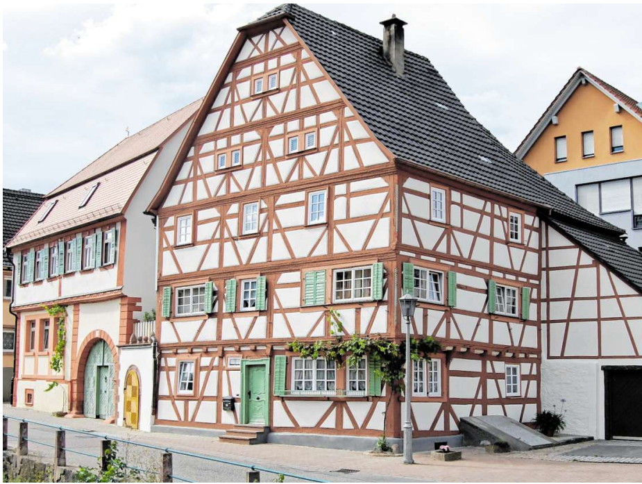
Ein Schmuckstück: Das 1659 gebaute Fachwerkhaus Waltert bildet zusammen mit der St.-Martins-Kirche, dem West-Flügel des Rathauses und dem sich bachaufwärts anschließenden „Gülden Löwen“ (links) ein ortsbildprägendes historisches Ensemble. Soeben wurde die aufwendige Sanierung des denkmalgeschützten ältesten bewohnten Gebäudes in der Gemeinde, die ohne jeden Zuschuss gemeistert werden musste, abgeschlossen.
