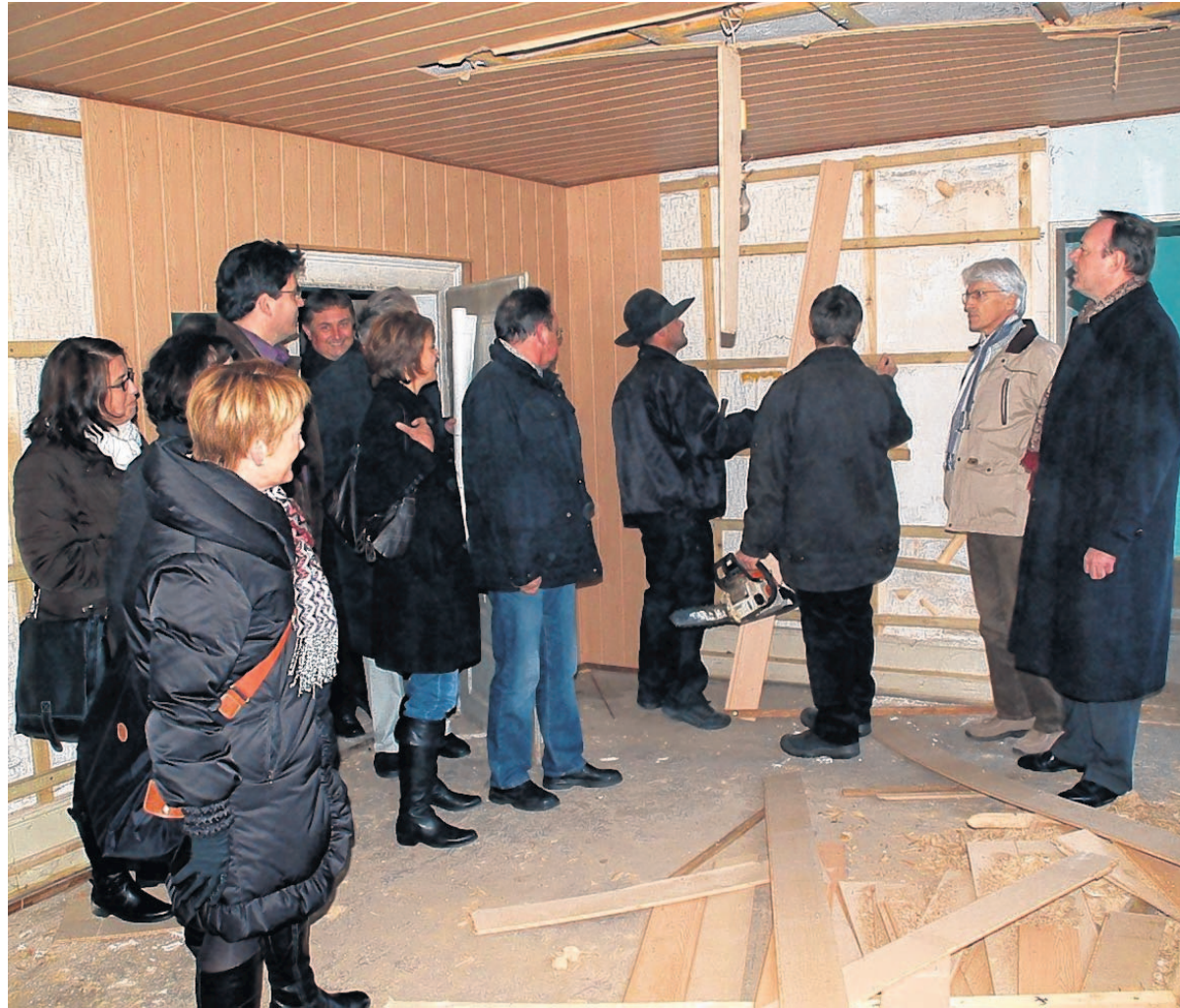
Mit Abbrucharbeiten und der Entkernung begannen am Mittwoch die Umbauarbeiten des Gebäudes Rathausstraße 24 in Lauda zum neuen Mehrgenerationenhaus und Pflegestützpunkt des Kreises.
